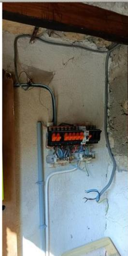
Description : Au moins un CONDUCTEUR isolé n'est pas placé sur toute sa longueur dans un conduit, une goulotte, une plinthe ou une huisserie, en matière isolante ou métallique, jusqu'à sa pénétration dans le MATERIEL ELECTRIQUE qu'il alimente.
